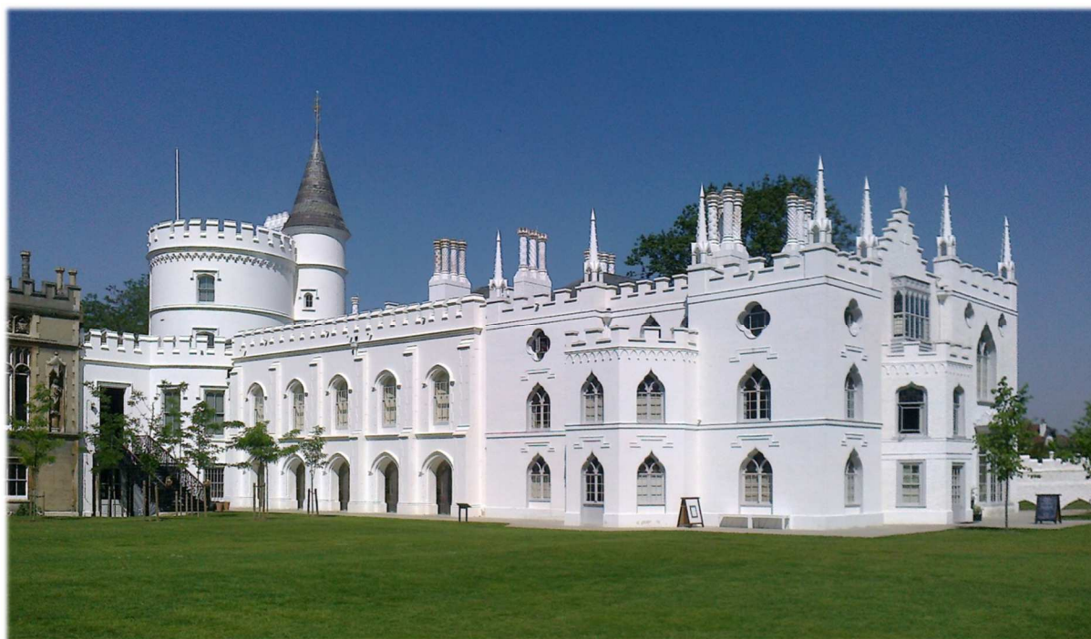
A felújított Strawberry Hill House homlokzata a kertből. Forrás: Wikipedia Commons
